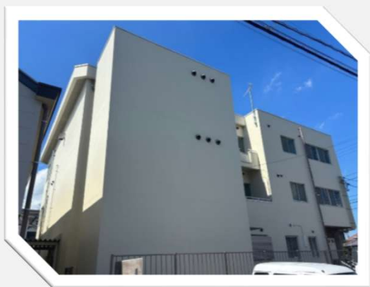
改修後の久米公民館
