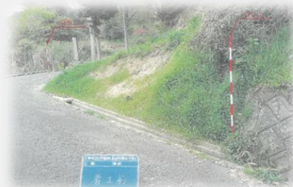
大西谷農道 着工前
