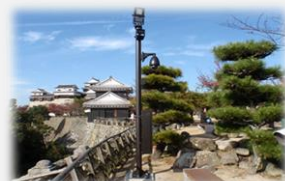
防災照明ポールを設置
